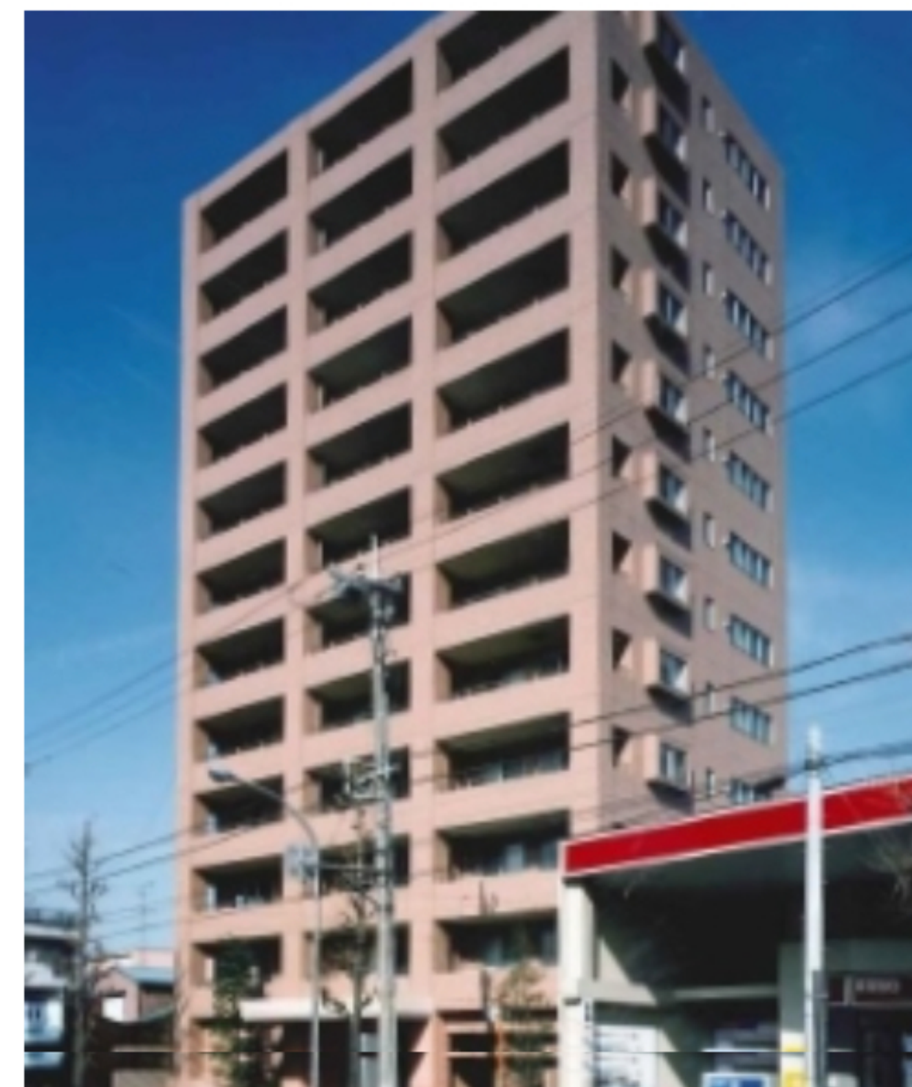
シテラ川崎クリスタルパティオ新築工事
