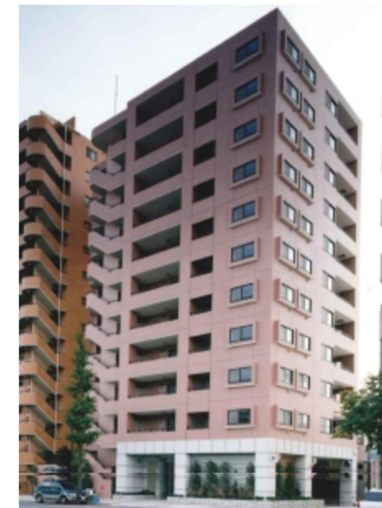
シテラ川崎グランフォンテ新築工事
